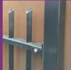
3.) Quadratstabfüllung 25/25mm Durchmesser spitz zulaufendem oberem Abschluss "Raute spitz"
