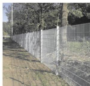
**Pulverbeschichtete Matten sind an den Knotenpunkten nach dem Schweißvorgang im Tauchbad nach DIN EN iso 1461 feuerverzinkt !**
